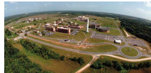
Entrée du Centre spatial guyanais, Port Spatial de l'Europe / The Guiana Space Center
